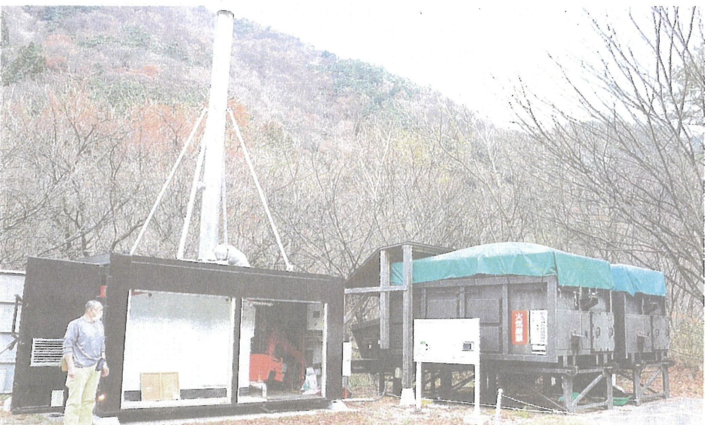
竜島温泉せせらぎの湯に設置されている木材チップのボイラー(左)と保管庫
